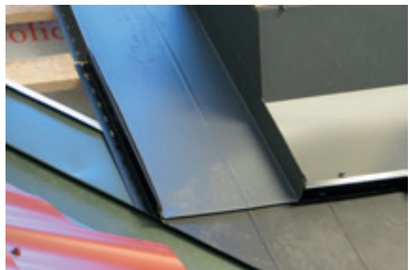
Obr. f – osadenie druhej šablóny z ľavej strany.
