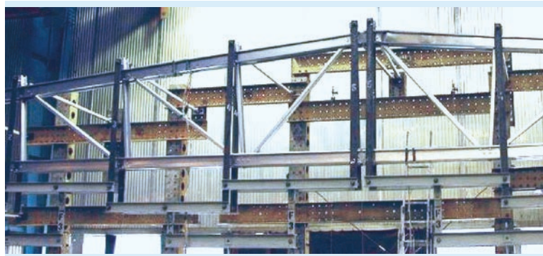
Obrázok 10. Výsledky predchádzajúcich laboratórnych skúšok vykonaných v spolupráci s BUTE boli zohľadnené pri definovaní nosnosti rámu SBS Maxi.
