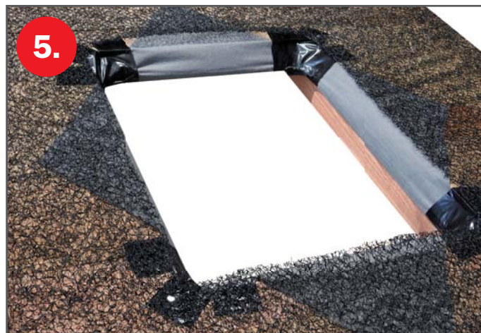
Příprava otvoru
