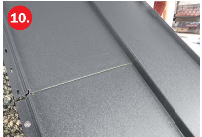
Do SPR se zasune ohnutý zástřih na horním dílu krytiny a tento díl se nacvakne do zámků.
