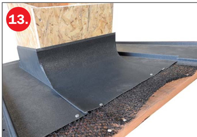
Sesazení zadního dílu lemování s díly bočními.
