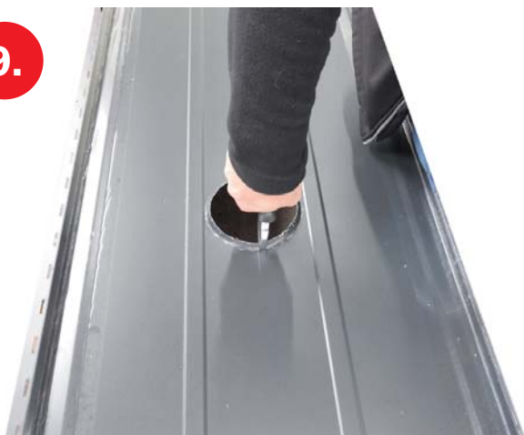
Postupujeme opatrně po obvodu. Plech nesmí prasknout
