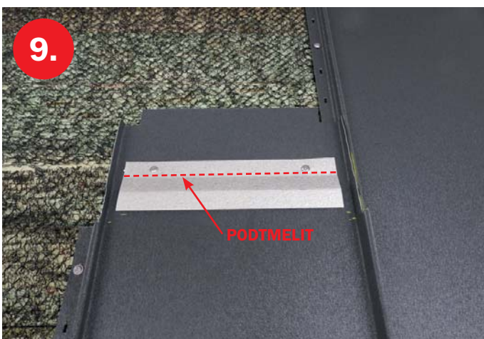
Díl SPR je nutno podtmelit, nebo podtěsnit butylkaučukovou páskou.
