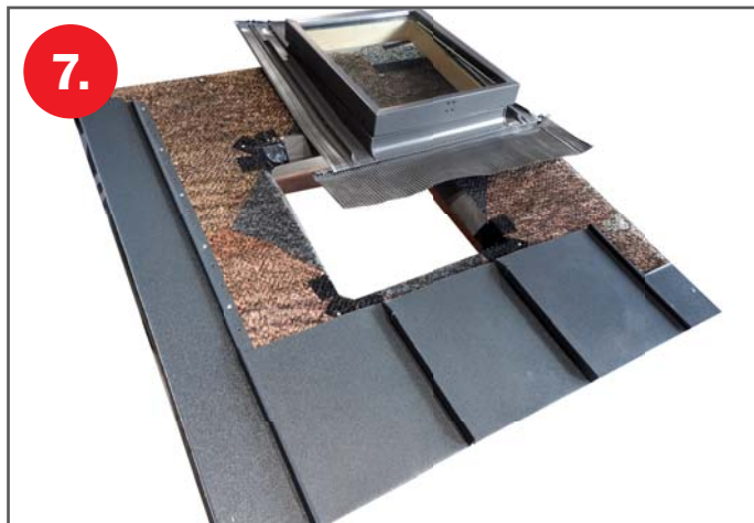
Příprava krytiny kolem výlezu. Montáž je možná jak z levé, tak z pravé strany. Úprava dílů krytiny pod výlezem.
