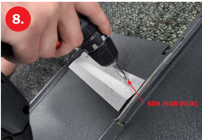
V místě osazení horního dílu krytiny se montuje „spojovací plech Rapid“ (SPR) pro zasunutí zástřihu.
