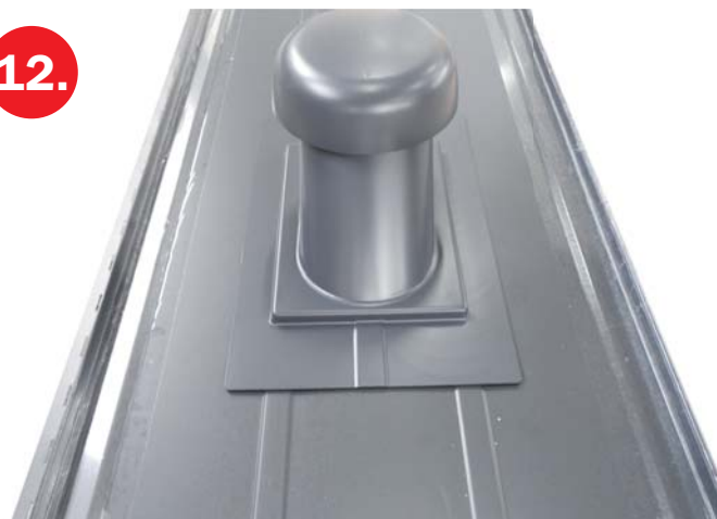
Do takto připraveného otvoru osadíme prostupující prvek a napojíme ho na komínek, nebo manžetu
