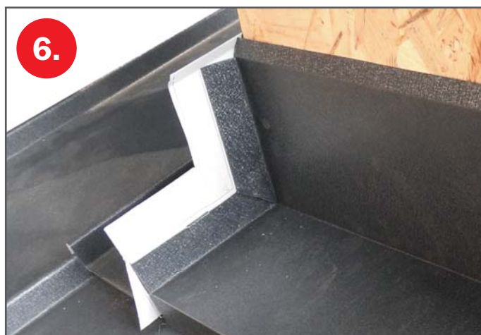
Sesazení spodního a bočních dílů lemování
