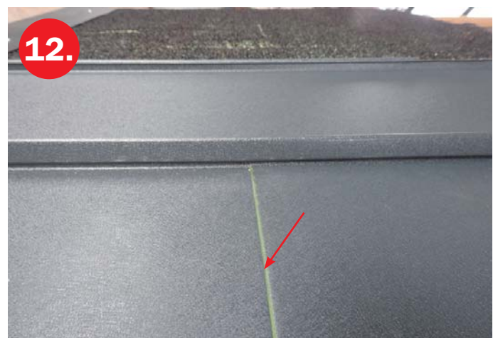
Lehkým poklepem paličkou je vhodné krytinu ve spoji stlačit.
