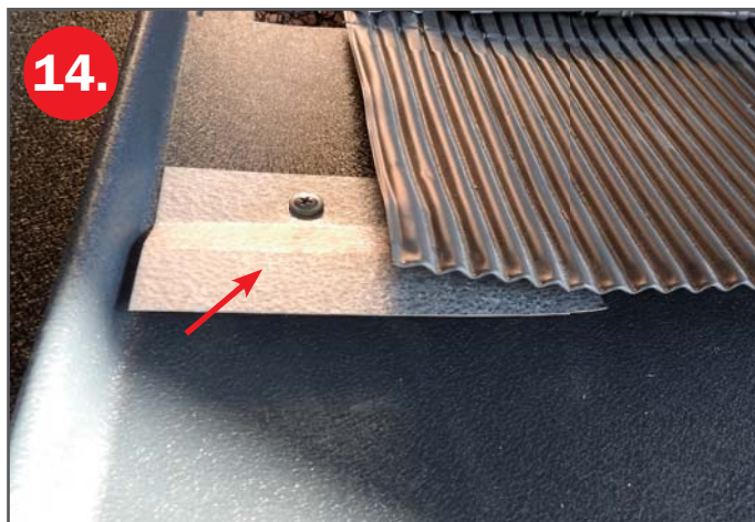
Délka Spojovacího plechu Rapid (SPR) musí být taková, aby tento díl zasahoval cca 50 mm pod manžetu. Spojovacího plechu Rapid (SPR) vždy podtěsníte tmelem, nebo butylkaučukovou páskou.
