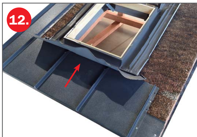
Před finálním osazením okna musí být na spodní stranu manžety aplikovaný butylkaučuková páska
