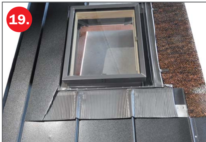
Osazení bočního dílu krytiny. Na druhé straně výlezu se postupuje shodně, ale až po instalaci krytiny nad výlezem
