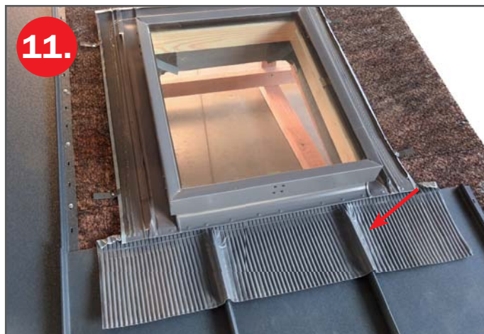
Precizní vytvarování manžety podle tvaru podkladu zajistí spolehlivou vodotěšnost
